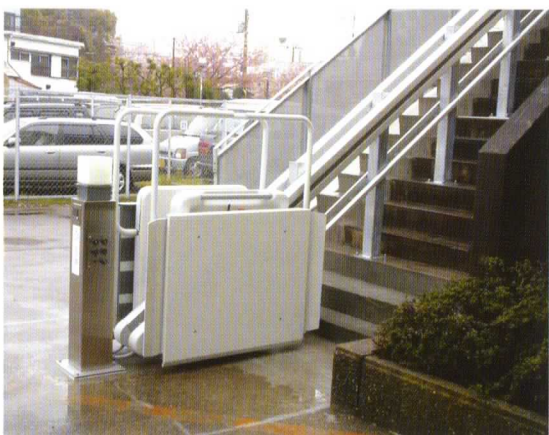
● 会社施設(埼玉県 綾瀬市) 多人数の車椅子使用者の為、2台のストレート型を配置しました。
